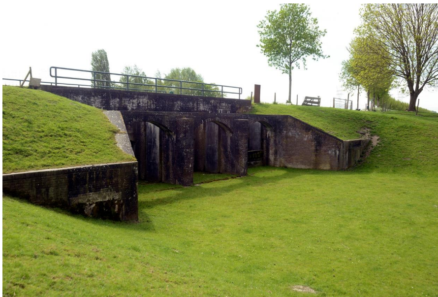
Noordkant van de Inundatiesluis Zuiddijk aan het Noord-Hollands Kanaal nabij Purmerend en gebruikt om de Beemster te inunderen
