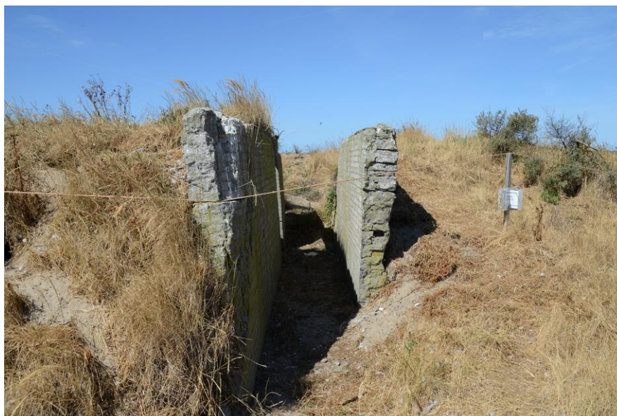
Overblijfsel van een loopgraaf als onderdeel van de Atlantikwall op het Forteiland IJmuiden
