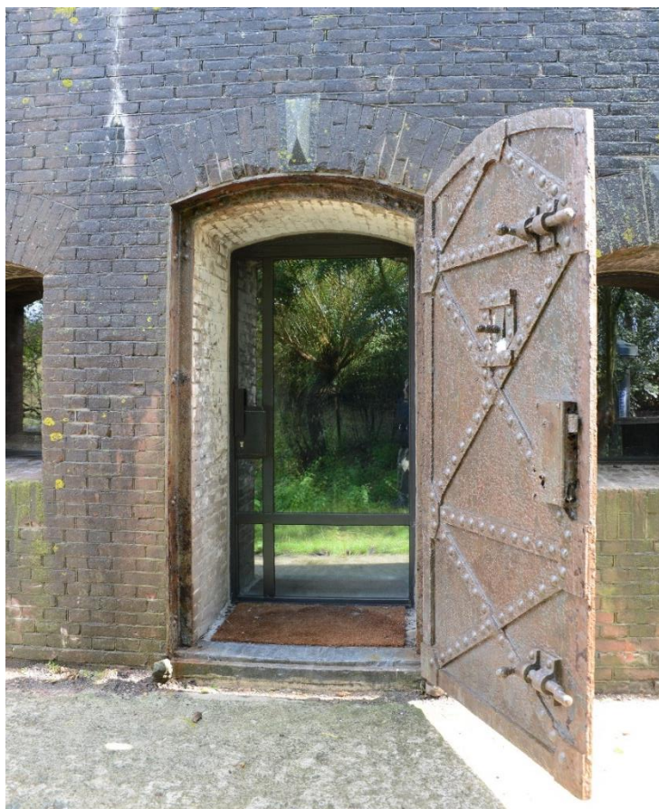
Fort op het Vuurtoreneiland onderdeel van Kustbatterij bij Durgerdam Geïsoleerde ziekenboeg die alleen via een buitendeur te betreden was (achter de buitendeur is een moderne glazen deur aangebracht die op de foto weerspiegelt)
